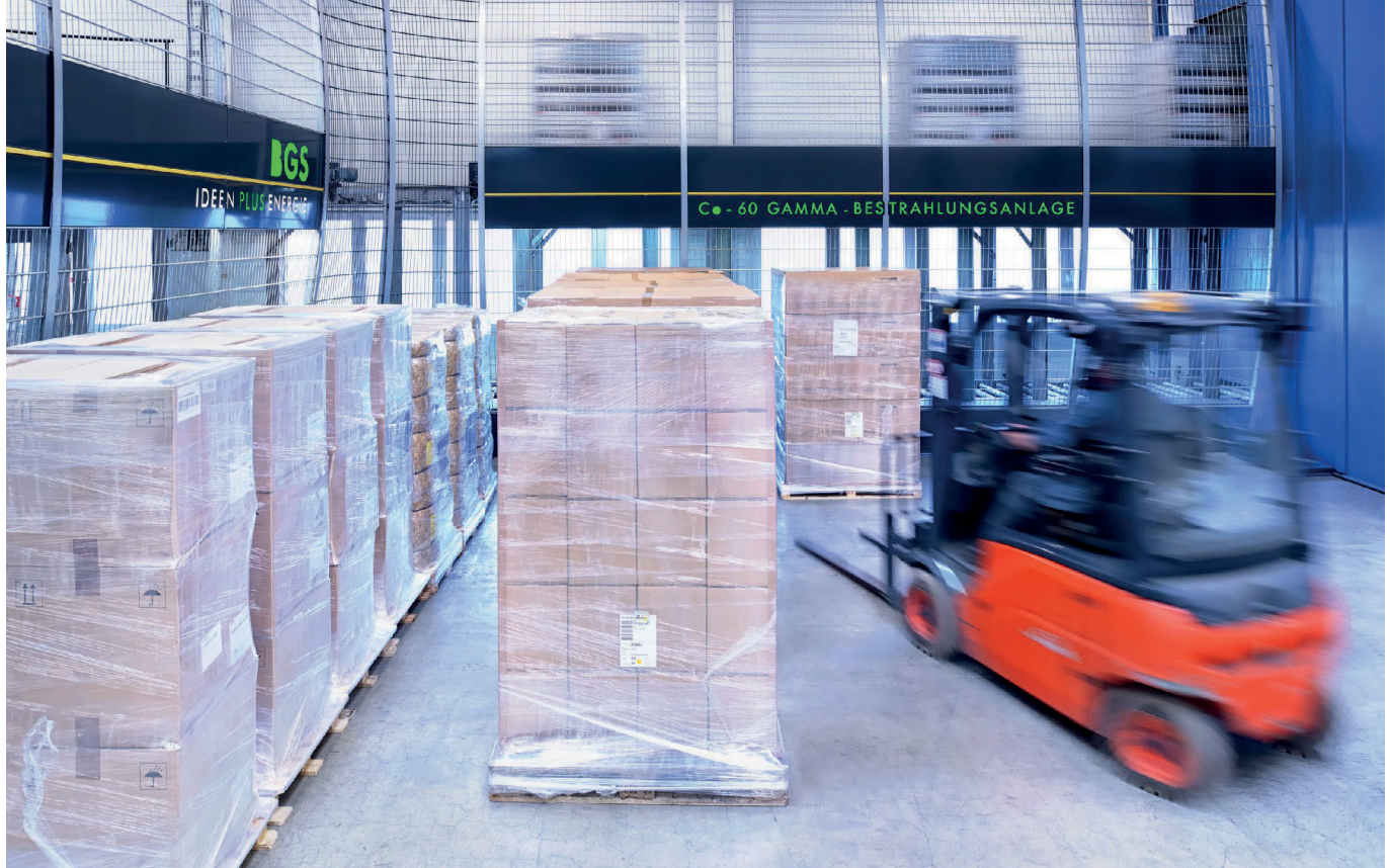
Produktionshalle der Gamma-Bestrahlungsanlage am Hauptsitz der Firma BGS in Wiehl.
